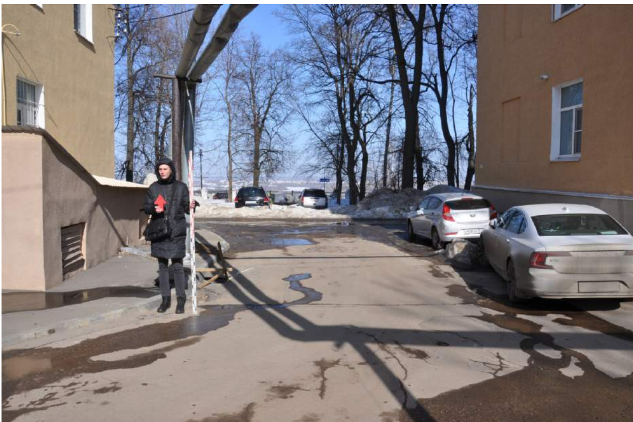
Рис. 15. Работы по проекту: «Строительство КЛ 0,4 кВ от РУ 0,4 кВ ТП-153 Нагорного РЭС» по адресу: г.Н.Новгород, Верхне-Волжская набережная, у д.14. 2024 г. Точка фотофиксация 3. Вид с Ю.
