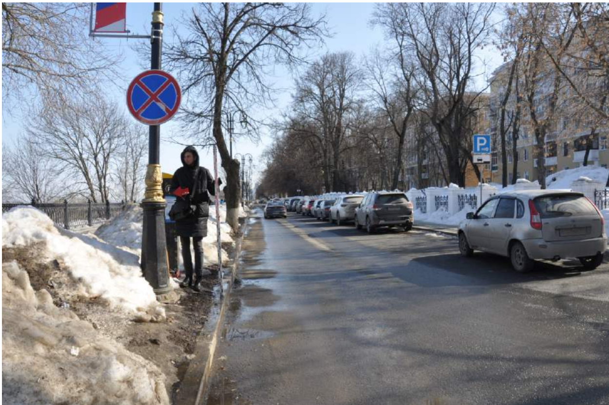
Рис. 12. Работы по проекту: «Строительство КЛ 0,4 кВ от РУ 0,4 кВ ТП-153 Нагорного РЭС» по адресу: г.Н.Новгород, Верхне-Волжская набережная, у д.14. 2024 г. Точка фотофиксации 1. Вид с З.
