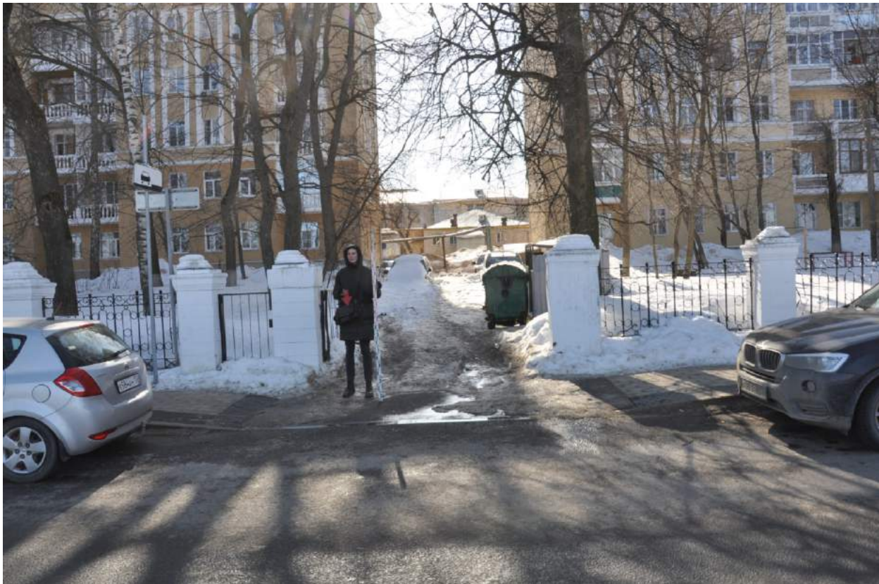
Рис. 14. Работы по проекту: «Строительство КЛ 0,4 кВ от РУ 0,4 кВ ТП-153 Нагорного РЭС» по адресу: г.Н.Новгород, Верхне-Волжская набережная, у д.14. 2024 г. Точка фотофиксация 2. Вид с С.
